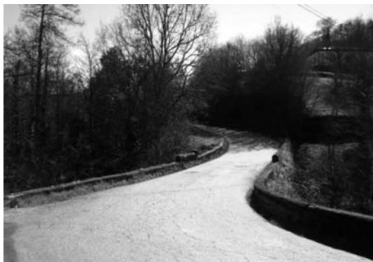
Antiga imaxe da ponte do río Bo.
